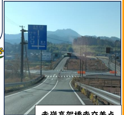
赤嶺高架橋南交差点
